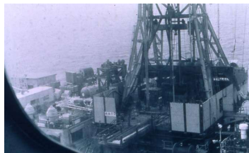
Vista ripresa da un elicottero di una piattaforma off-shore per l'estrazione di idrocarburi
